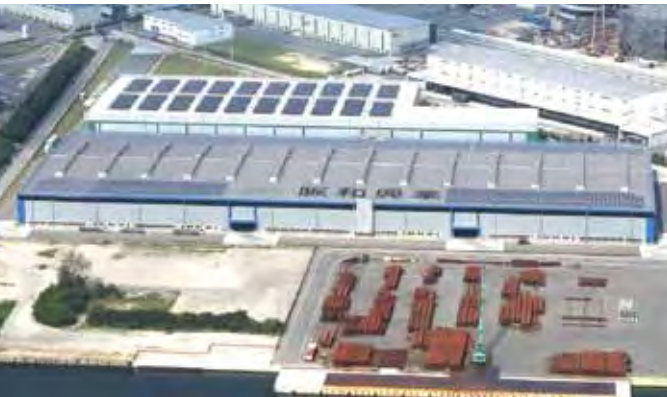
南棟（写真手前）に新たに設置された太陽光発電パネル
