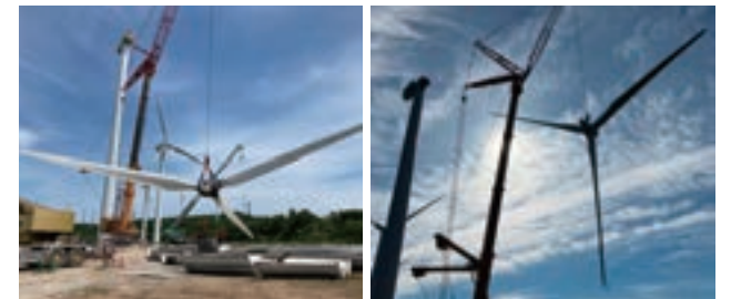
風力発電の解体
