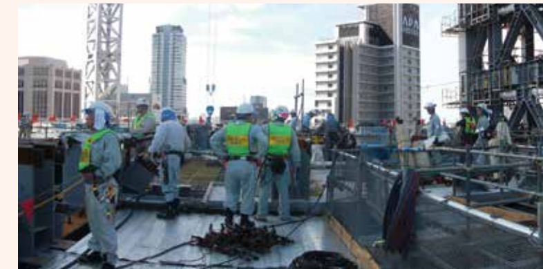
安全パトロールの様子
