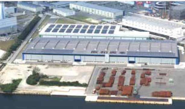
南棟（写真手前）に設置された太陽光発電パネル
