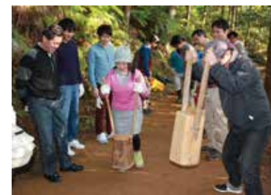
土を固める作業は「タコ」という道具を使います
