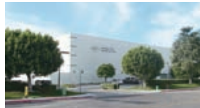
コイルセンター外観
