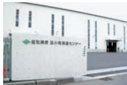
流通センター外観
