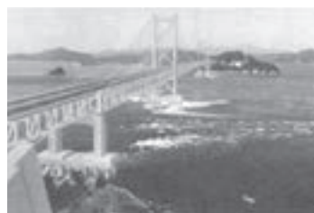
本州四国連絡橋大鳴門橋(1976年7月着工・1985年6月8日開通)
