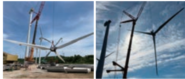
風力発電の解体
